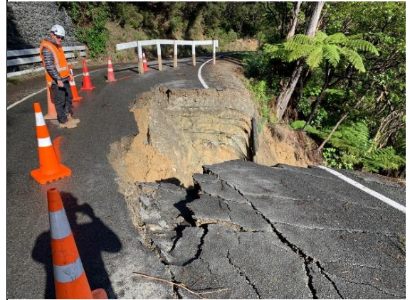
Kenepuru Rd at Torea Rd
