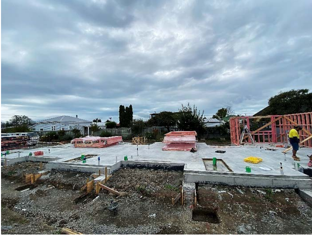
Fig 5: Concrete pad pour Stage 1
